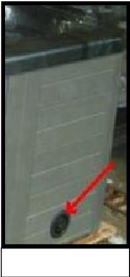
En caso de utilizar la toma de agua tenga en cuenta que es una válvula de dos posiciones que según como esta girada puede dejar o no la entrada de agua. Una vez esta en posición “entrada de agua “(cuando la válvula está metida hacia dentro) empezar el llenado.
